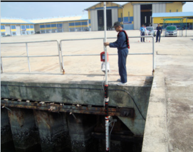
Lokasi pemasangan tide gauge di Jeti UniKL – MIMET
