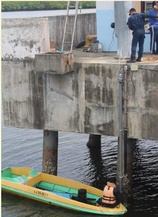
Pemasangan tolok pasang surut
