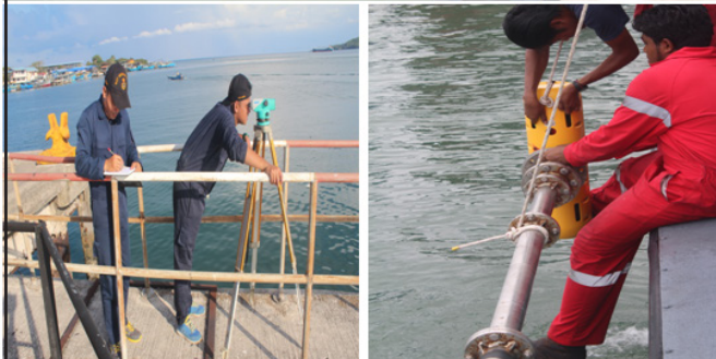
Pengelasan dan Pemasangan Peralatan
