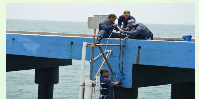
Kerja-kerja Pemasangan Tide Gauge dan Tide Pole.
