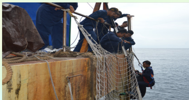
Kerja-kerja Pemasangan Tide Pole.
