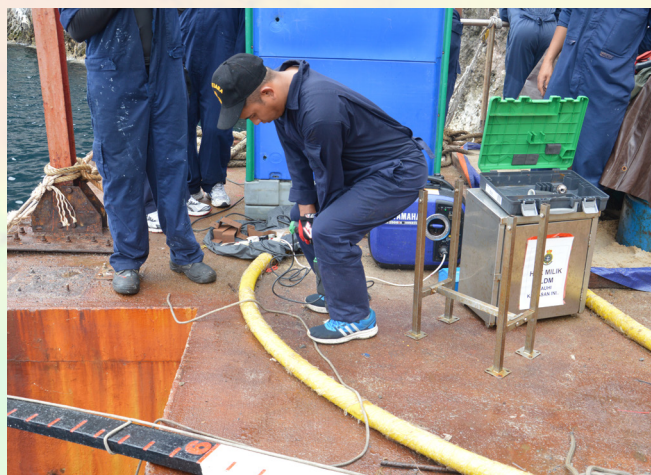
Kerja-kerja Pemasangan Rumah Tide Gauge.
