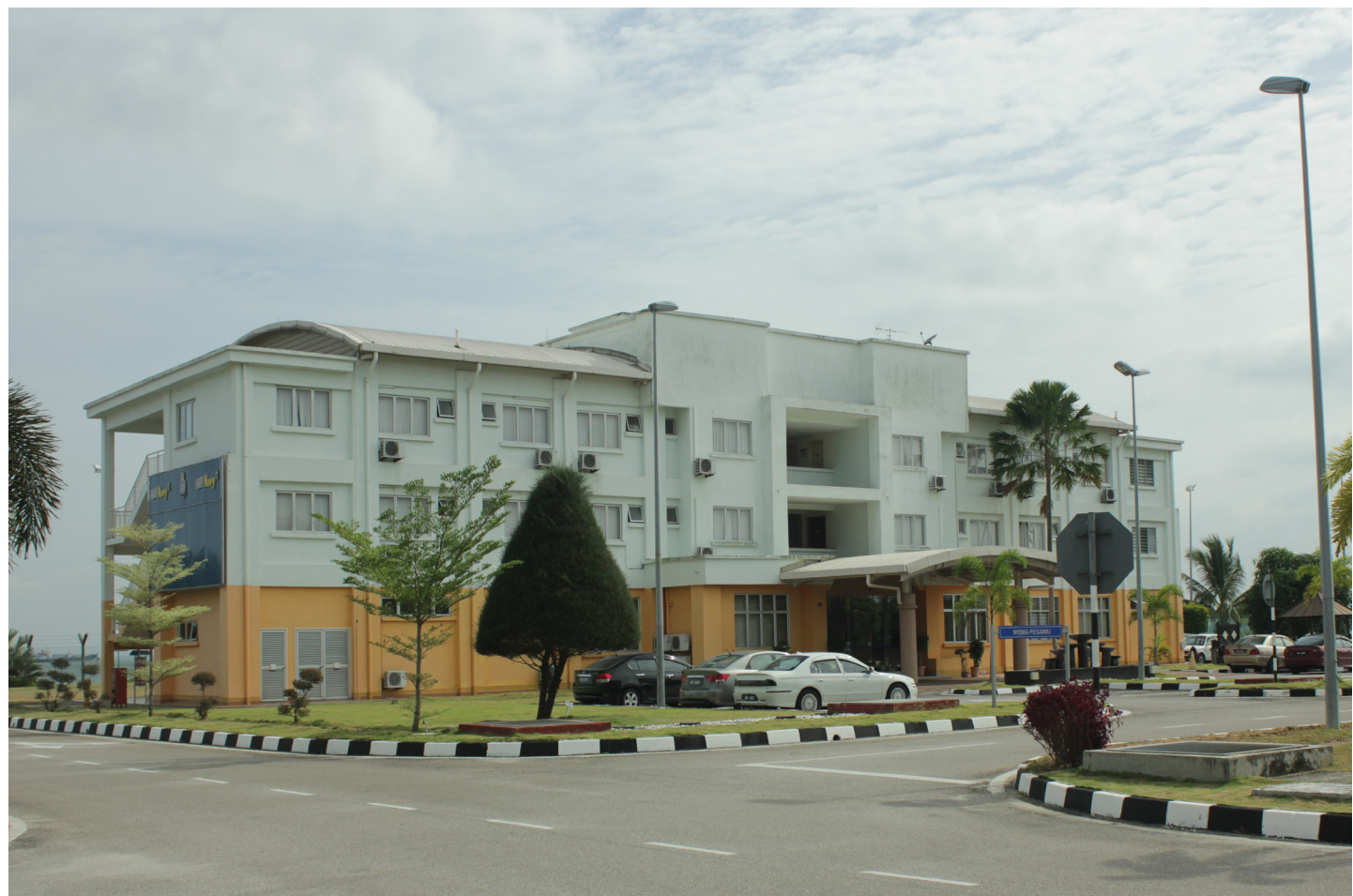
Wisma Indah (Wisma Pegawai) Pangkalan TLDM Pulau Indah
