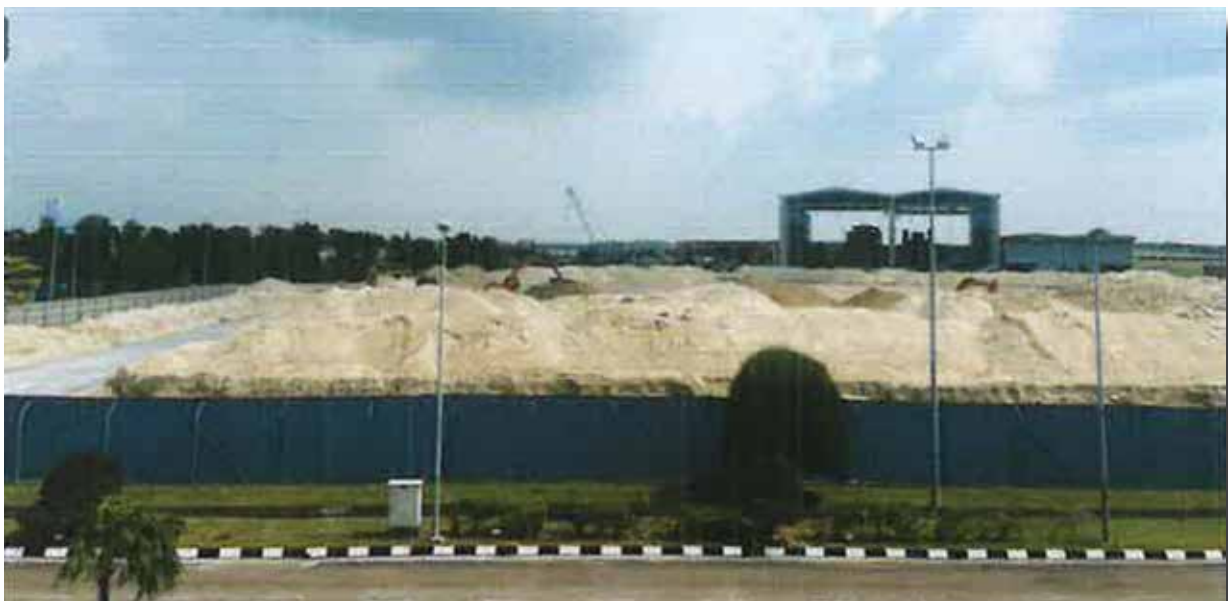
Gambar 1: Kerja-kerja menambak dan meratakan pasir di tapak projek RKAT PHN
